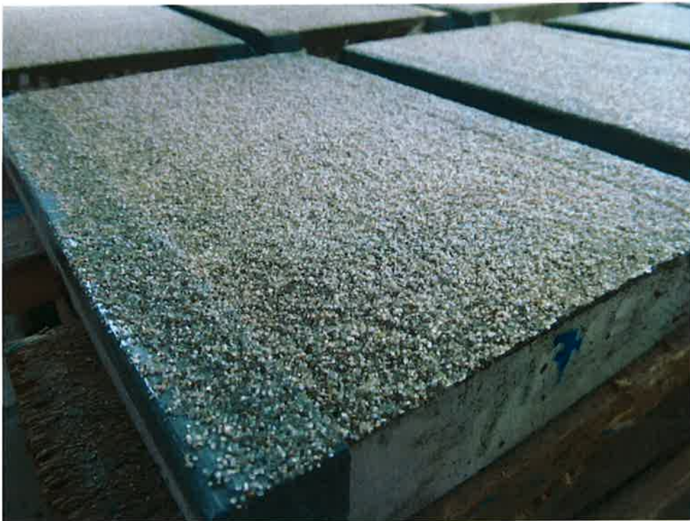
Bild 3 dito, nach Abstreuen mit Quarzsand
